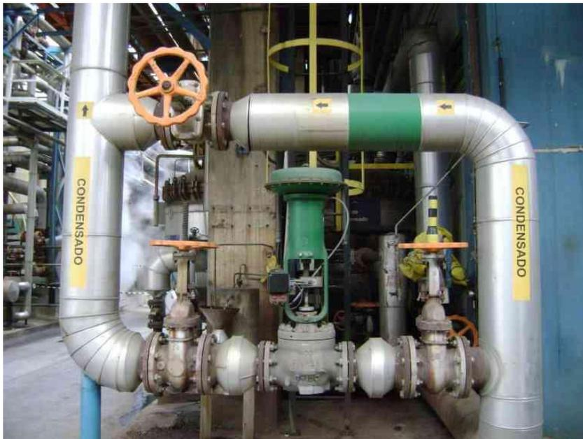
Estas válvulas têm a função de provocar uma queda de pressão (dissipação da energia produzida pelo escoamento do fluido) controlável ao processo e que depende do posicionamento do obturador. Elas são denominadas de elementos finais dentro de uma malha de controle.
