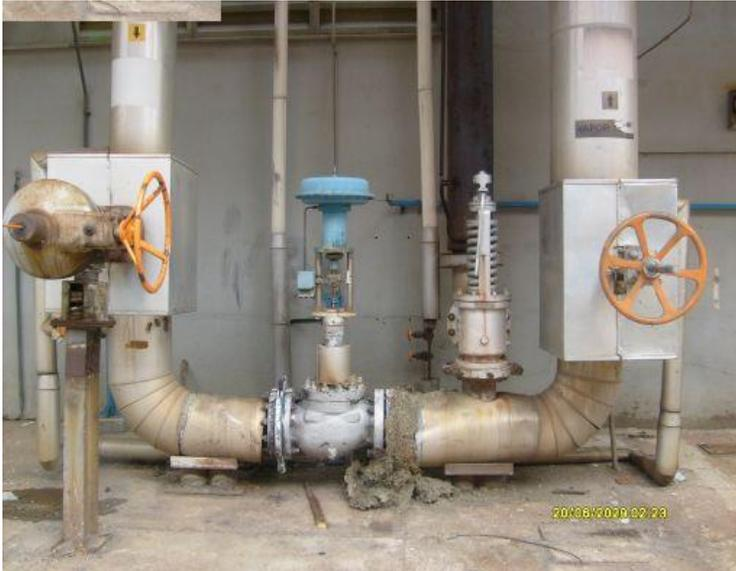
A figura ao lado mostra uma típica instalação de redução de pressão dentro de um processo industrial:
